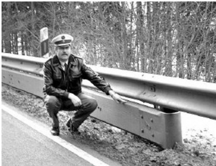
Mit dem so genannten Euskirchener Modell werden Schutzplanken für verunglückte Motorradfahrer sicherer.
